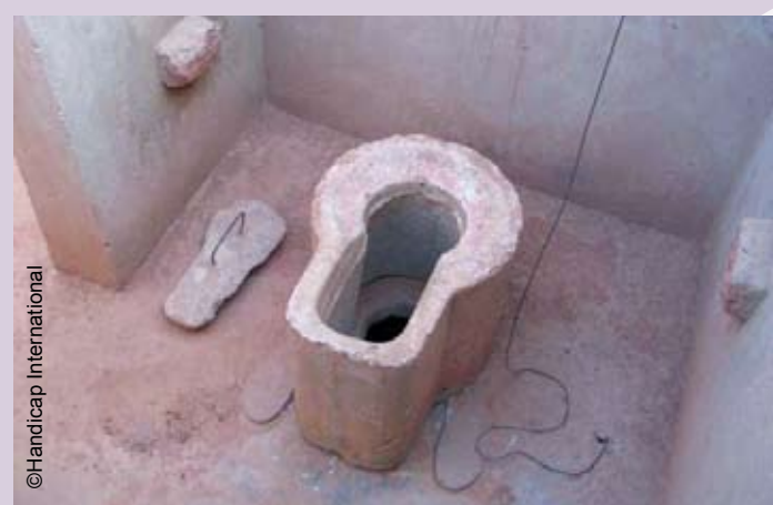
▲ Surélévation des latrines et fil de repérage
